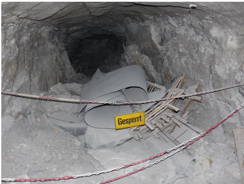
Foto 4: Zugang zum Durchhieb zwischen ELK 8/750 und Abbau 9/750 mit Abschaltungen an den Stößen; Aufnahme vom 19.05.2014
