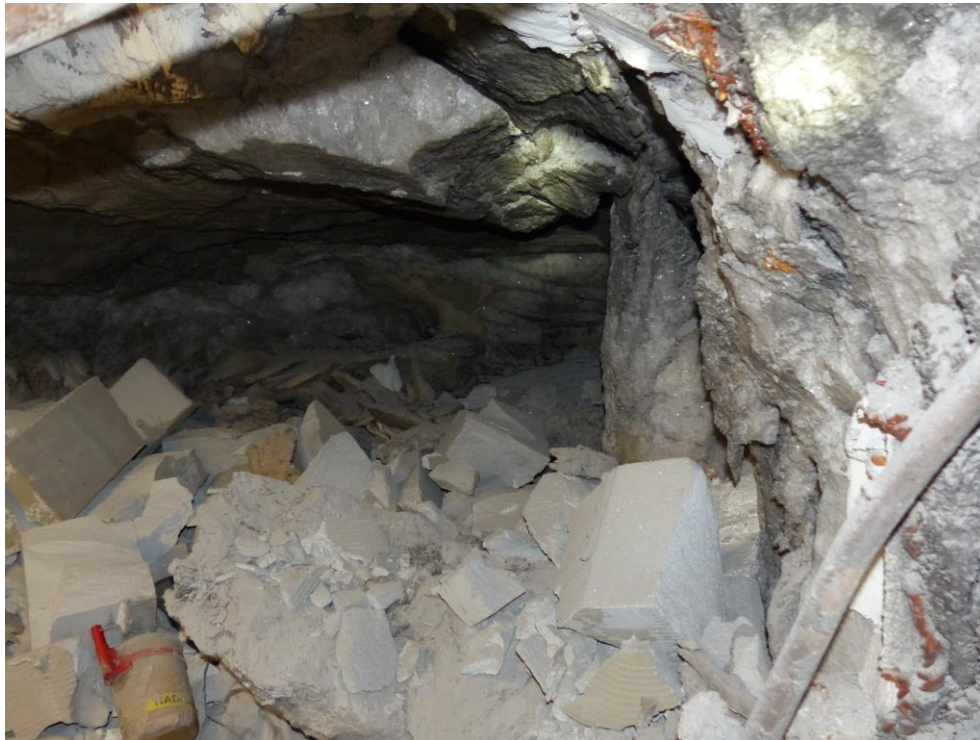
Foto 3: Östlicher Zugang zur ELK 8/750 mit erheblichen Entfestigungserscheinungen und zerfallener Mauer; Aufnahme vom 19.05.2014
