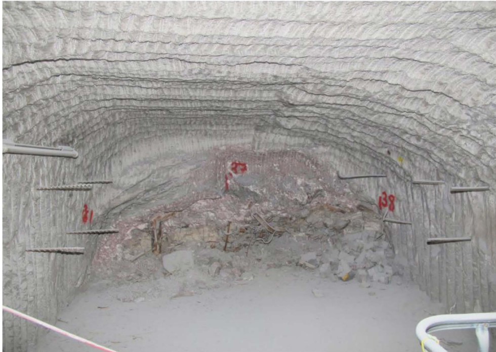
Foto 9: Nische im Bereich der 2. südlichen Richtstrecke nach Westen mit der lithologischen Grenze Na3/K2C; Aufnahme vom 21.03.2014
